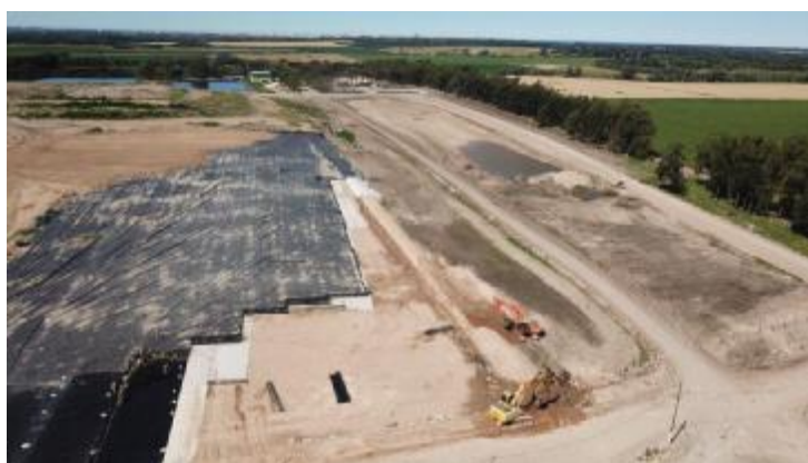
Etapas constructivas Sector B –Módulo 1- Impermeabilización
