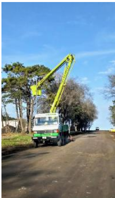
Tendido eléctrico – cierre anillo
