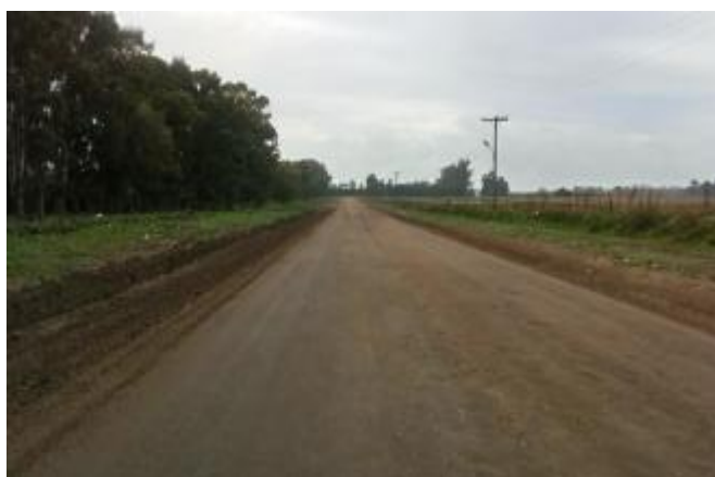
Camino acceso Calle 461
