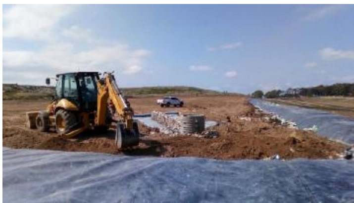
Construcción sumidero dren pétreo
