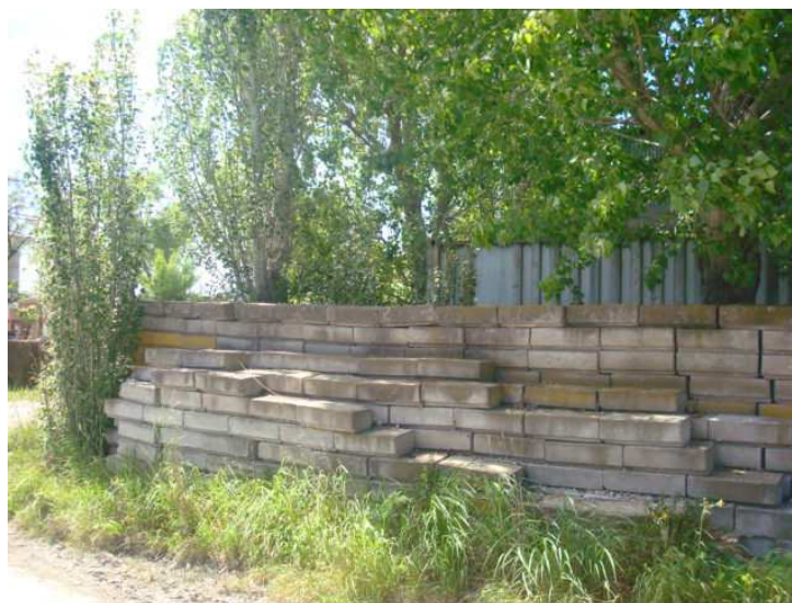
Foto Nº4. Bloques de Hormigón
